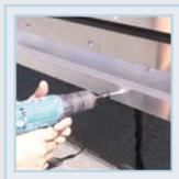
4. Fixer la coiffante au niveau de la retombée. Les fixations seront adaptées aux types de support et auront un écartement maximal de 450 mm.
